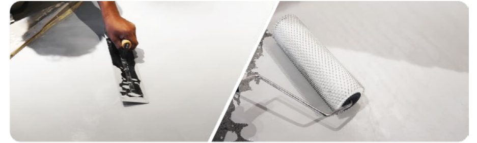
STEP 2 : MOISTURE BARRIER
